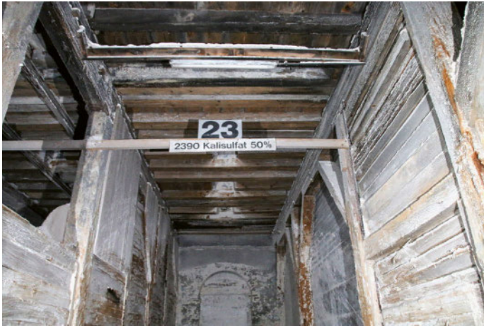
Blick in die alten Lagerhallen der Chemiefabrik.
